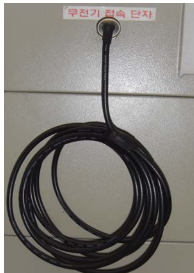
그림 6 무선기기 접속단자와 케이블
